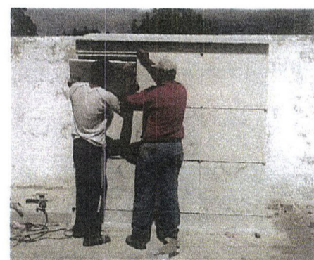
Ossários em construção
